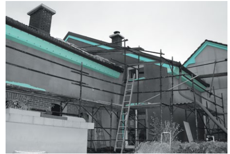
Beirais do telhado revestidos com FIBRANxps ETICS. A espessura depende do vão do telhado.
