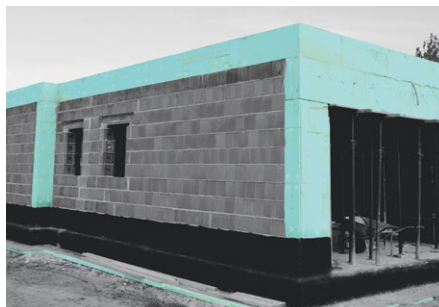
Isolamento das pontes térmicas da viga com FIBRANxps ETICS
