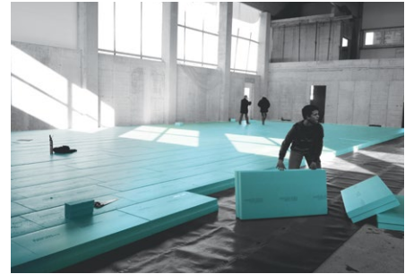
Aplicação de isolamento térmico FIBRANxps 500-L sob uma laje de fundação de um edifício multi-funcional
