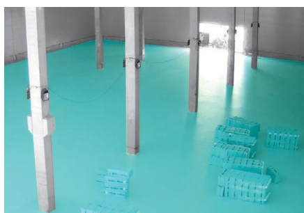
Isolamento térmico de uma sala de refrigeração com FIBRANxps 500-L e 700-L
