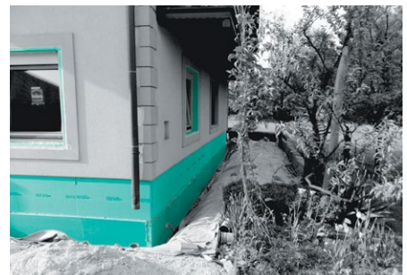
Correcção das pontes térmicas existentes no vão das janelas e portas e isolamento térmico do soco da fachada com FIBRANxps ETICS
