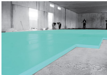
Isolamento térmico do pavimento de um pequeno armazém com FIBRANxps 300-L
