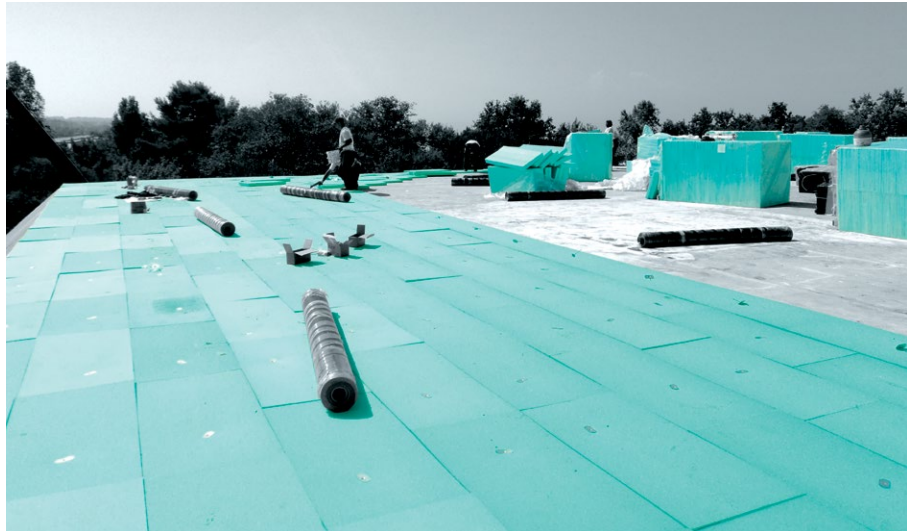
Aumento da inclinação da cobertura com FIBRANxps INCLINE e em simultânea reabilitação da cobertura plana
