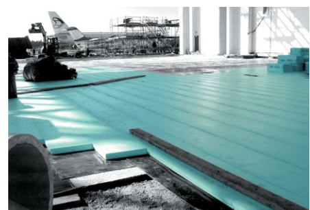
Protecção térmica do pavimento de um hangar de aviões com FIBRANxps
