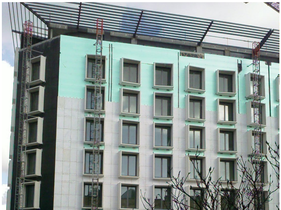
Revestimento em pedra de um edifício de hotel com isolamento resistente à carga FIBRANxps ETICS BT, ao qual a pedra natural é fixada através de um procedimento especial
